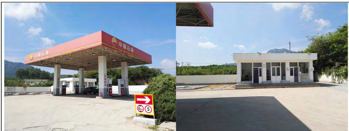
蓉花山加油站现状照片
