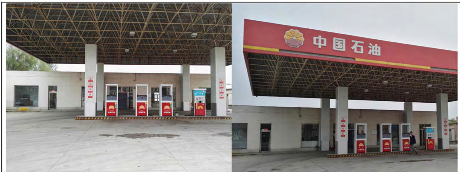
石城加油站现状照片
