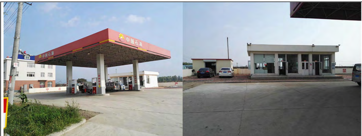
大营加油站现状照片
