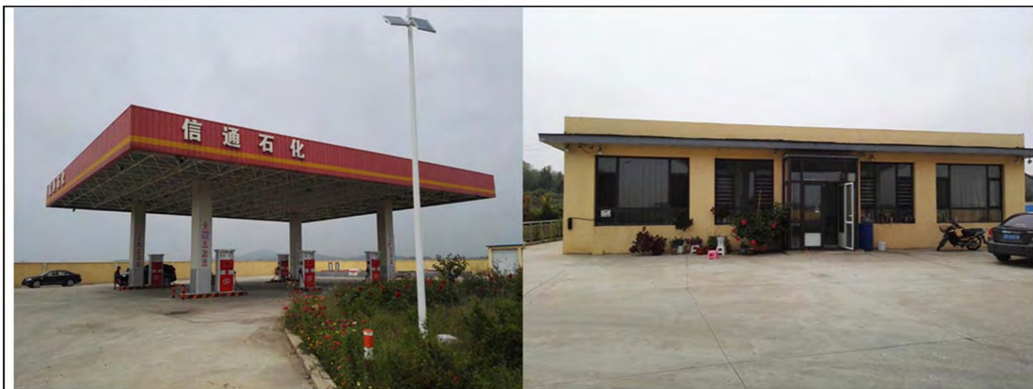
鹏达加油站现状照片
