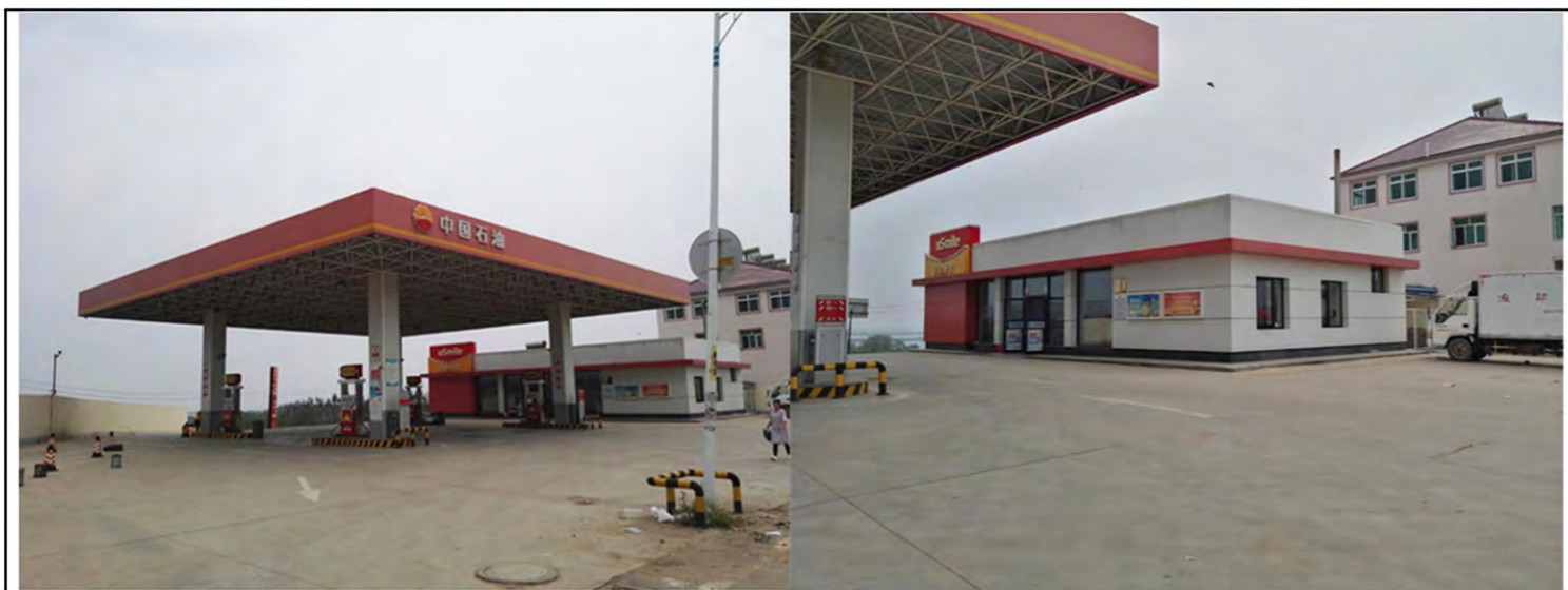
南尖加油站现状照片
