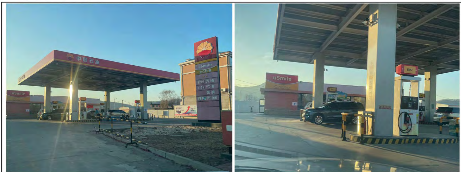
御河加油站现状照片
