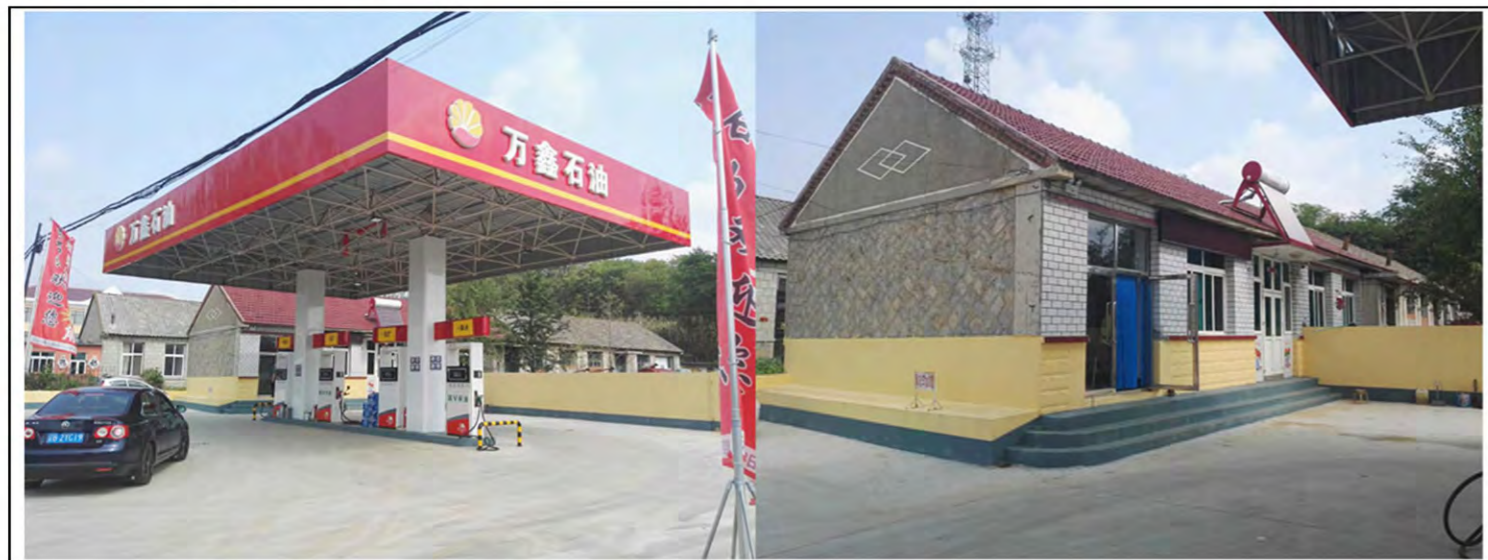
万鑫加油站现状照片
