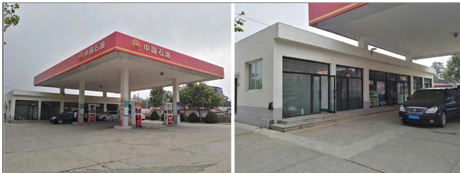
黄海加油站现状照片
