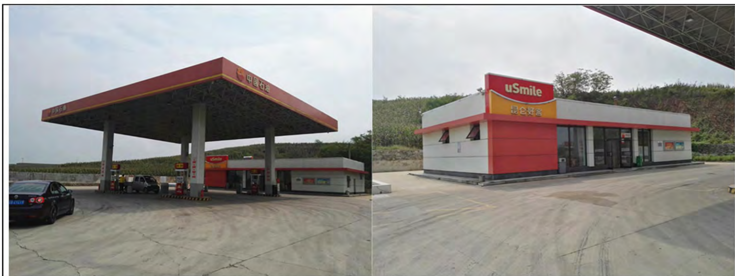
兴隆加油站现状照片
