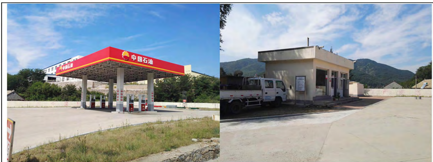
荷花山加油站现状照片
