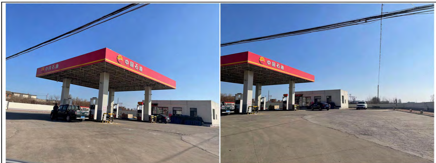
明阳街加油站现状照片
