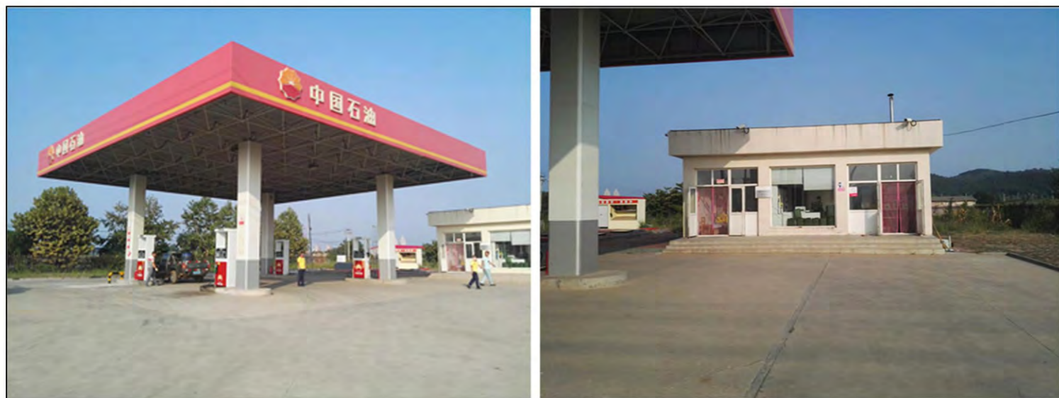
昌盛加油站现状照片
