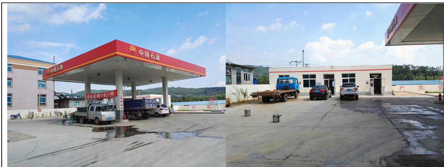
冰峪加油站现状照片
