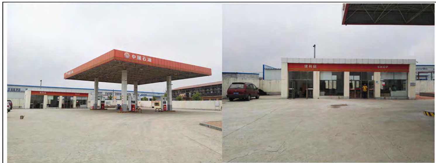
桃源加油站现状照片
