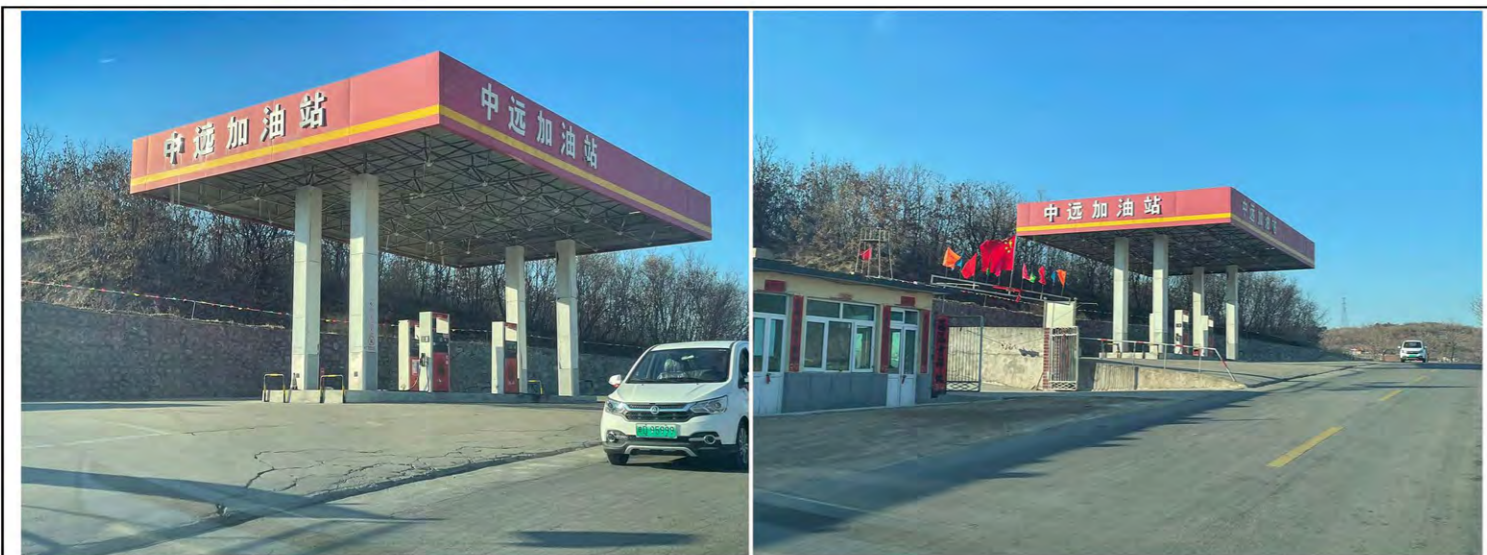
中远加油站现状照片
