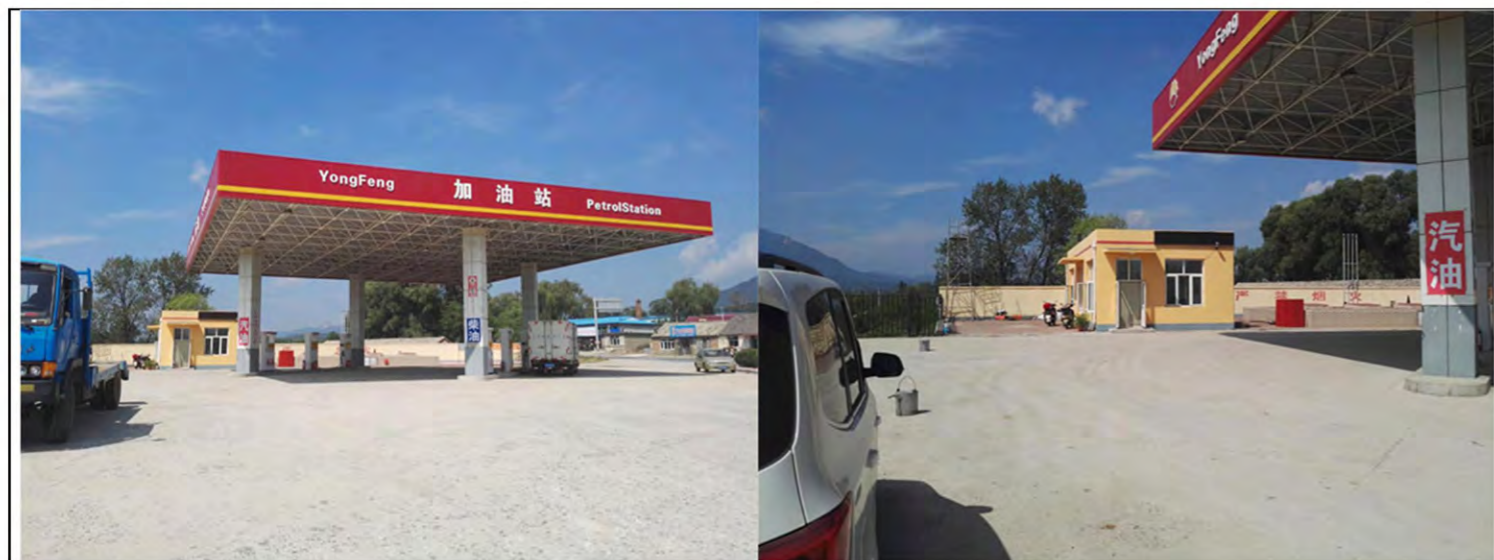
永峰加油站现状照片
