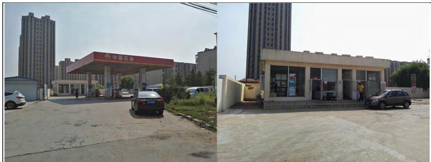
河东加油站现状照片
