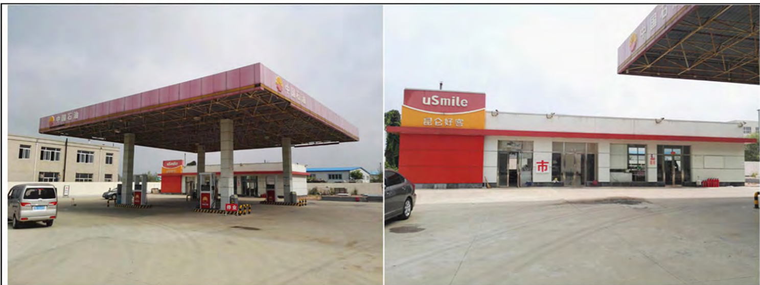
衣屯加油站现状照片
