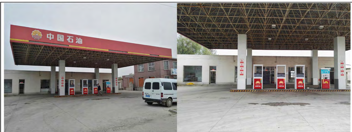
小孤山加油站现状照片
