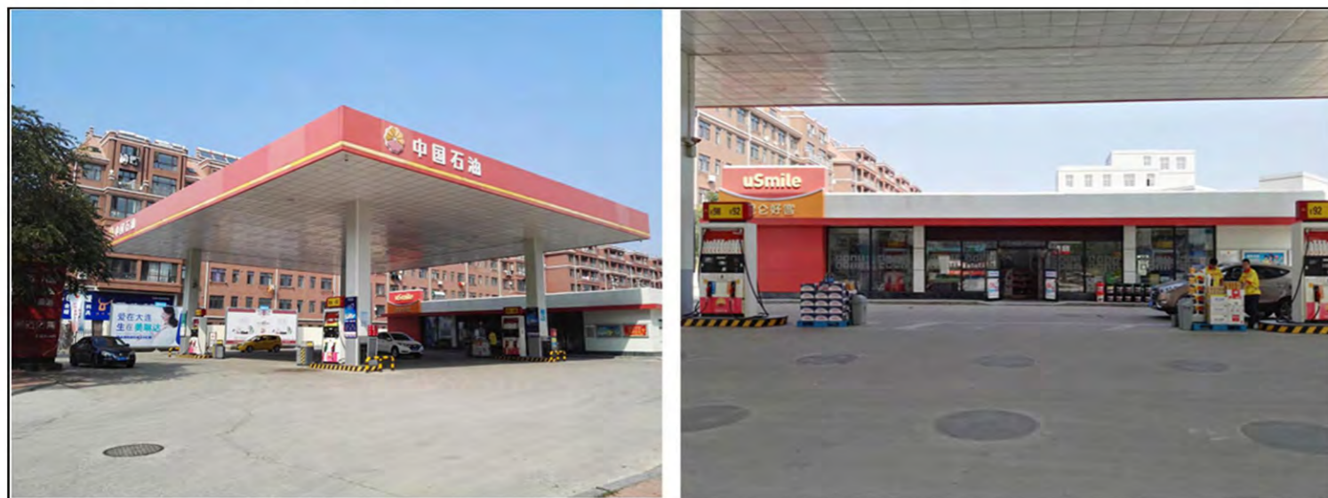
延安路加油站现状照片
