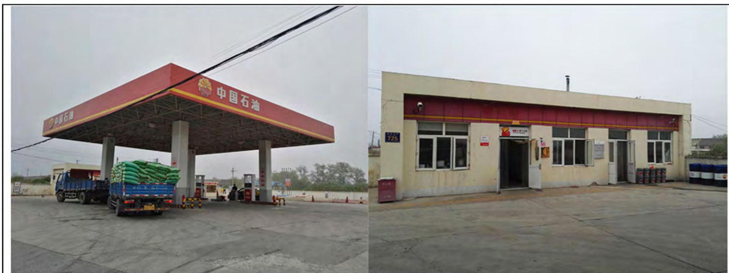
吴炉加油站现状照片
