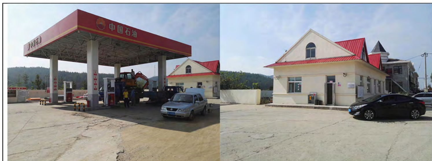
城山加油站现状照片
