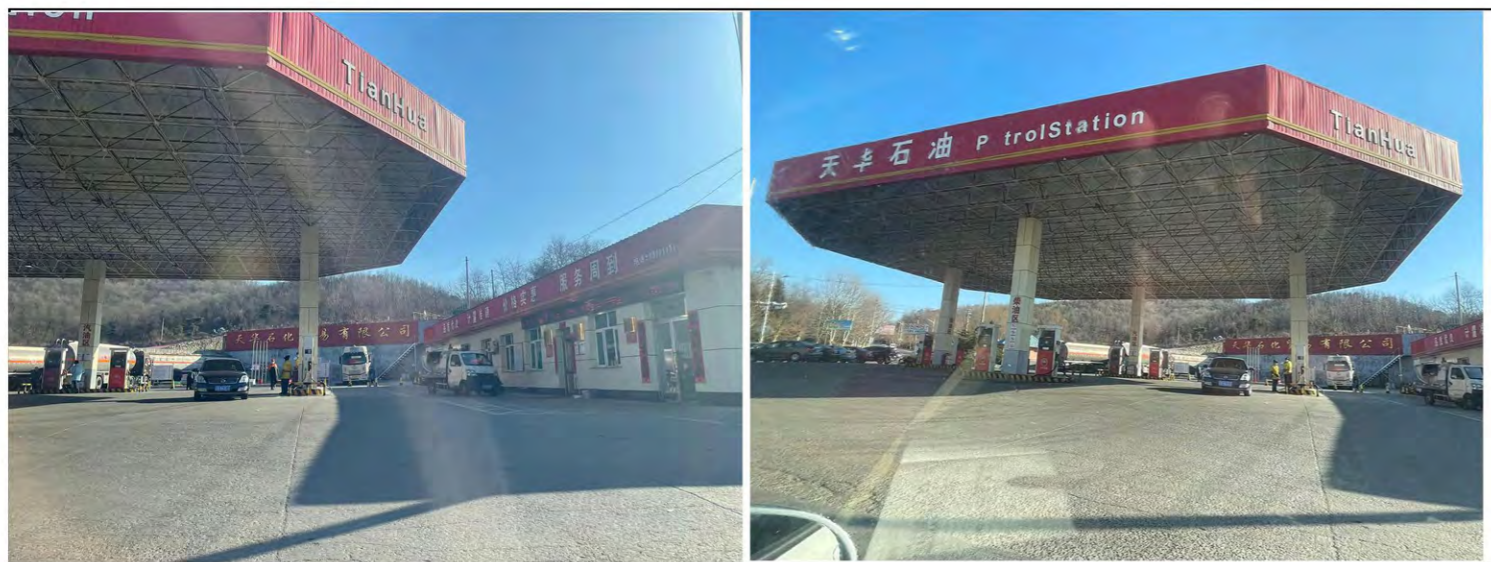
庆伟加油站现状照片
