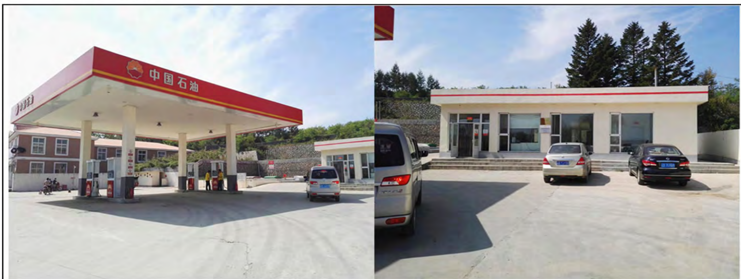
万巨加油站现状照片
