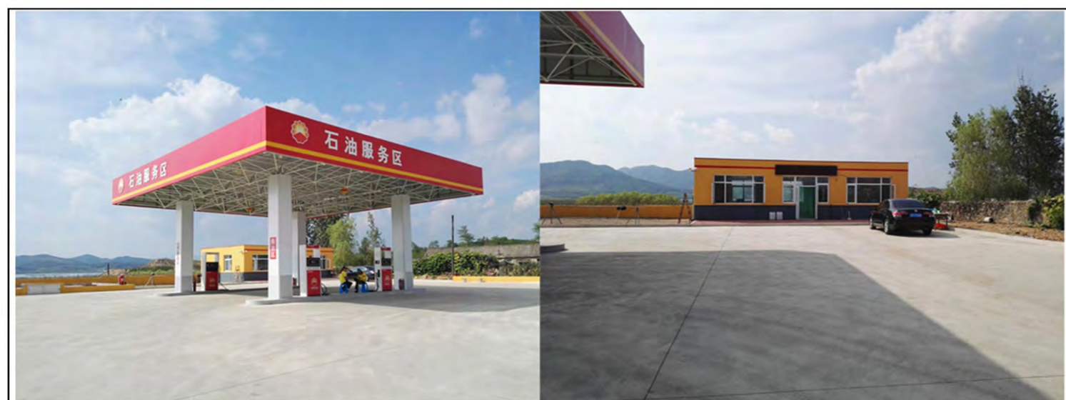
塔岭镇加油站现状照片
