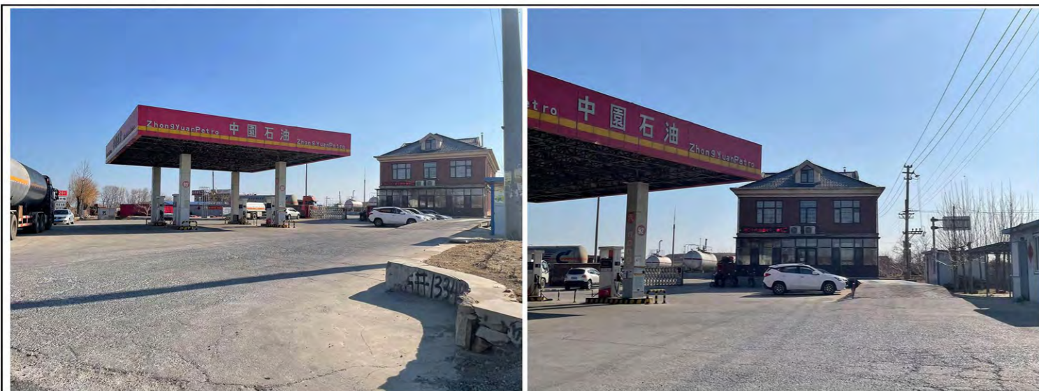
中园加油站现状照片
