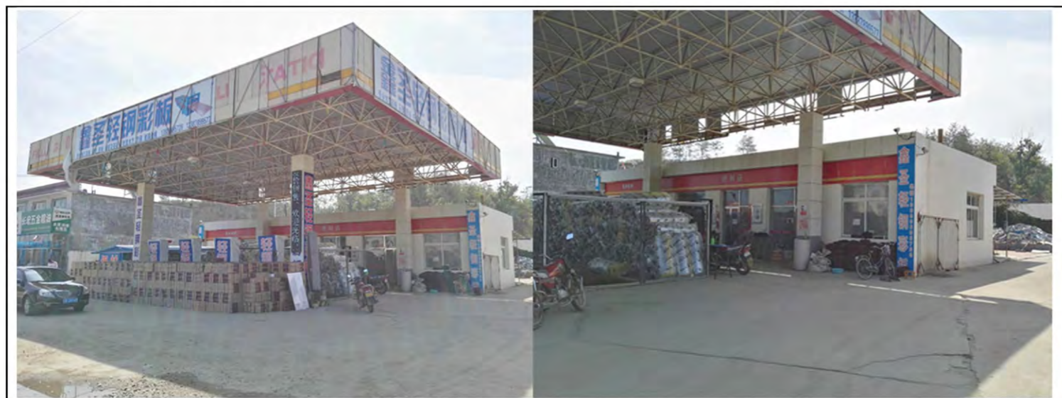
大张加油站现状照片
