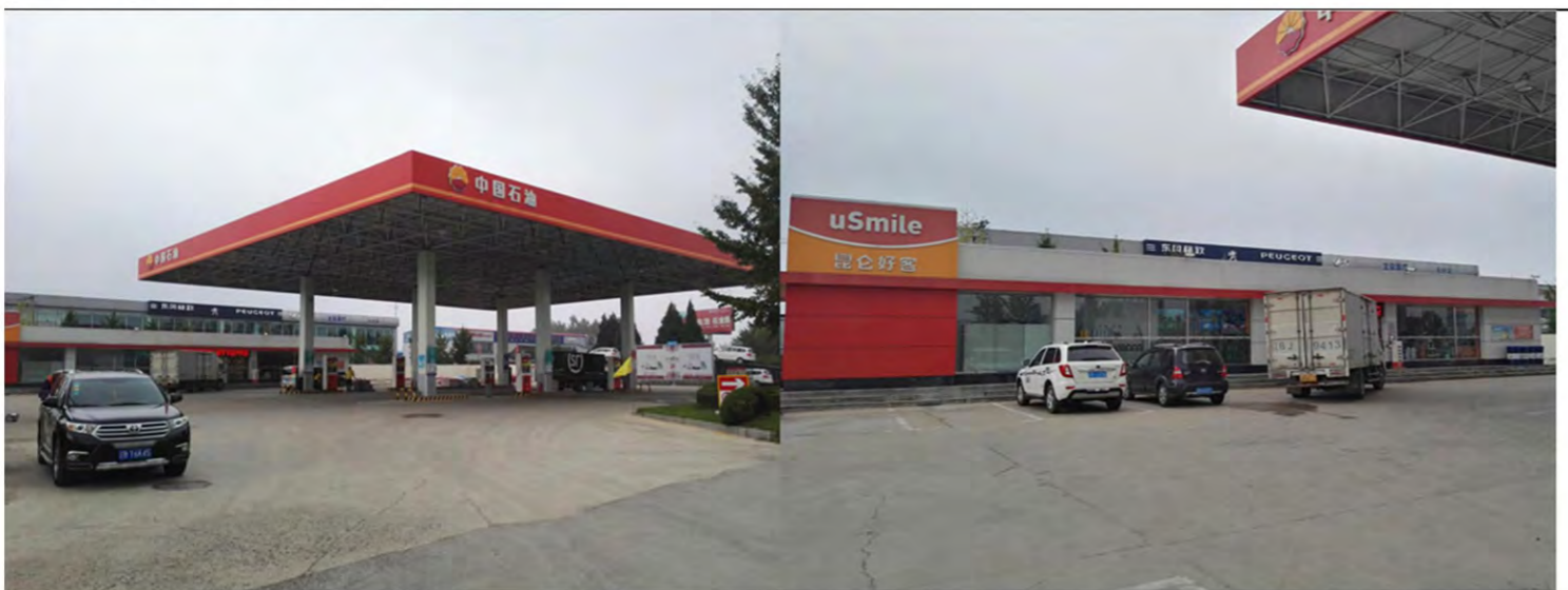
三环加油站现状照片
