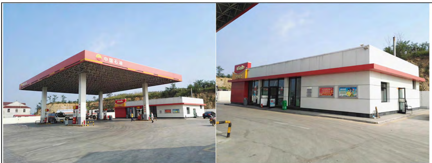
宋派加油站现状照片
