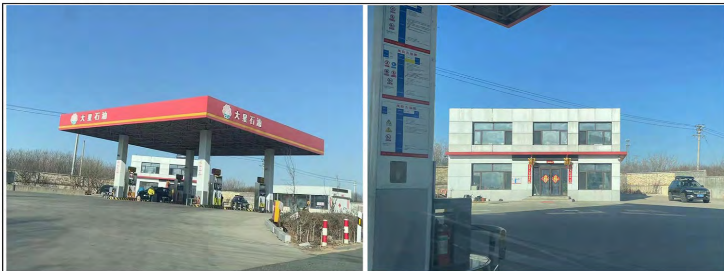
大星加油站现状照片
