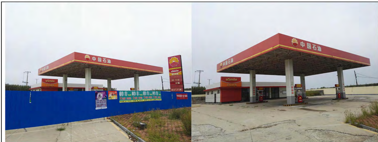
和平加油站现状照片
